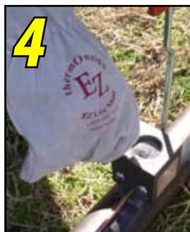
4 Pour weld metal into mold.
