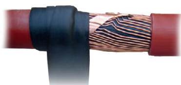
Paso 2. Encinte 2 capas a medio solape la zona dañada
